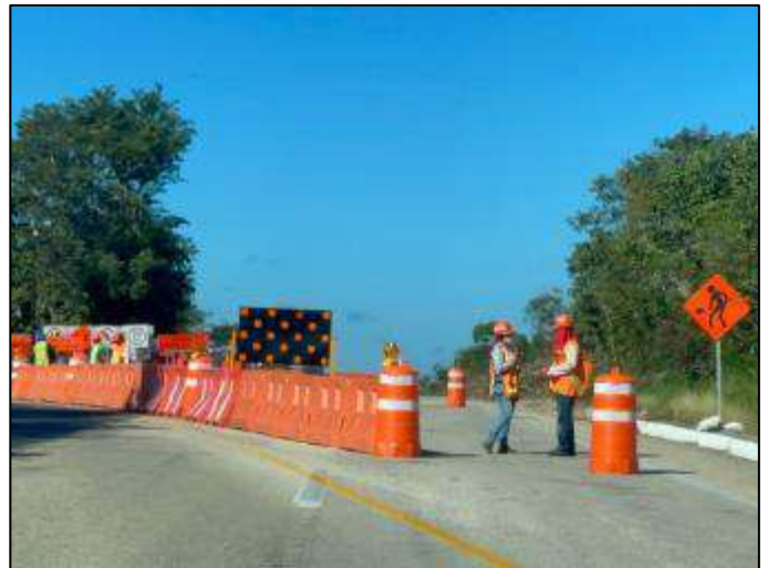
Obra en proceso de Cancún-Kantunil, km 124+000 y terminación en el km 116+00, aproximadamente km 8.
