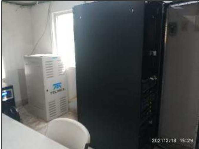
Site en Plaza de cobro "Chichen-Itzá", en buenas condiciones, km 115+500.
