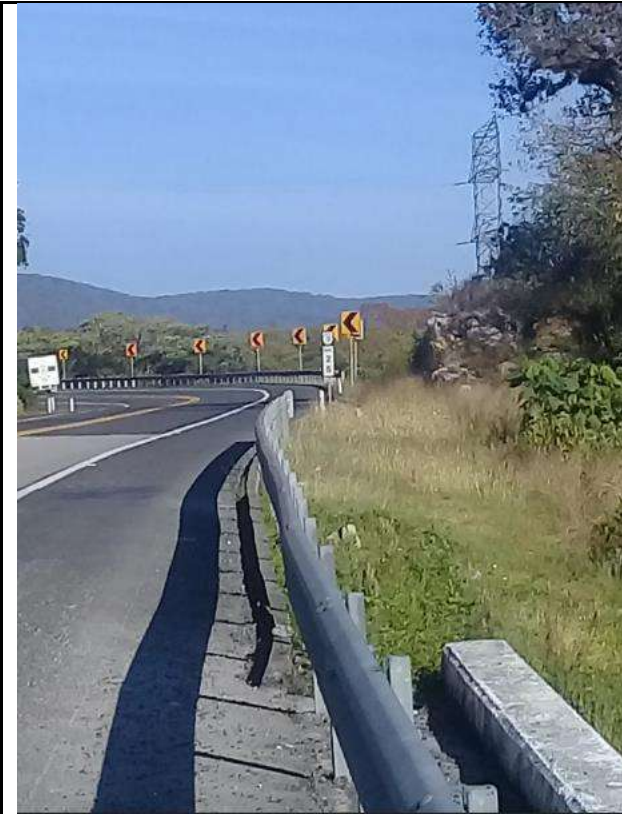
Pavimento con conservación reciente de basalto y caliza, con barreras de dos crestas, señalamiento vertical y horizontal correcto.
