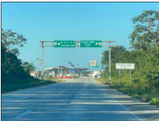
Señal informativa de destino y de información general, en buenas condiciones físicas, km 216+000.
