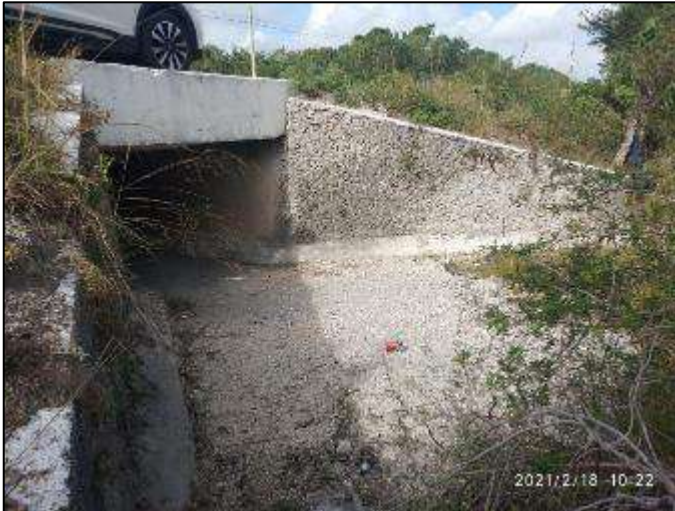
Obras de drenaje, Ramal Aeropuerto, en buenas condiciones.
