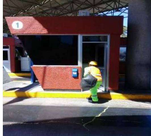
Estructura de caseta de cobro, en buenas condiciones físicas.
