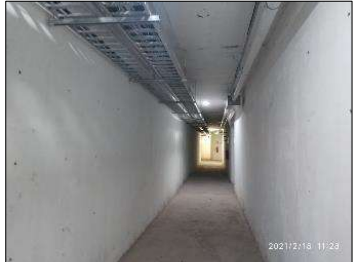
Trincheras en Plaza de cobro "Tintal", en buenas condiciones, km 237+700.
