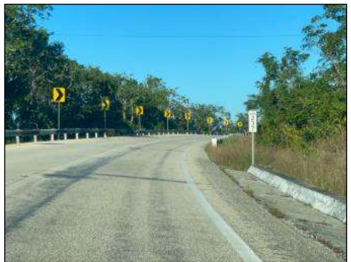
Señal preventiva sentido de curva y señal de identificación, en buenas condiciones físicas, km 237+000.
