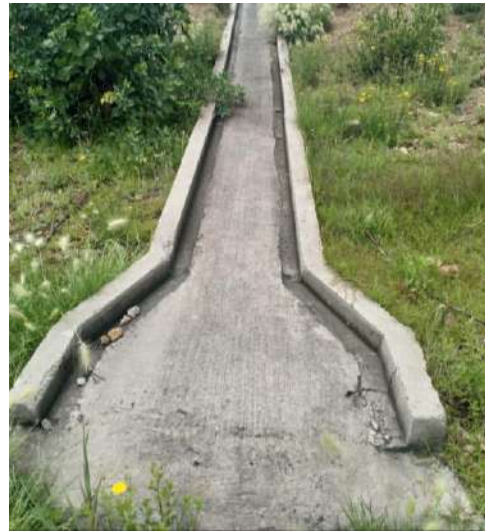
Obras de Drenaje
