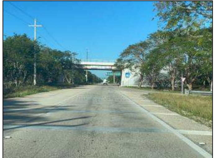
Rayas con espaciamento logarítmico para velocidad de entrada de 60 km/h, en condiciones regulares km 156+000.
