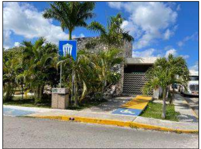
Instalaciones de sanitarios en Plaza de cobro "Chichen-Itzá" en buenas condiciones, km 115+500.
