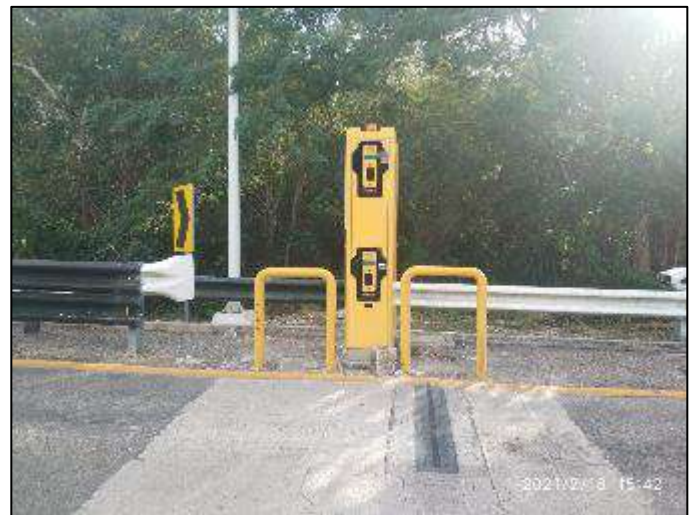
Boletería en Plaza de cobro "Chichen-Itzá" en buenas condiciones, km 115+500.
