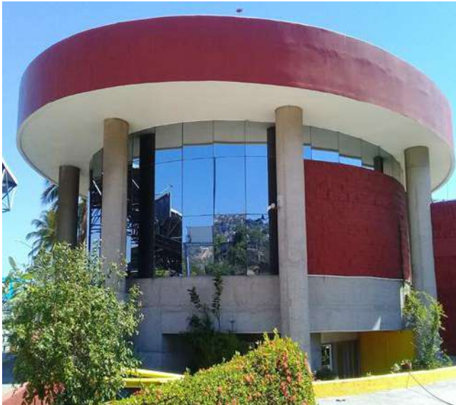
Edificio del Centro de control, en buenas condiciones físicas.
