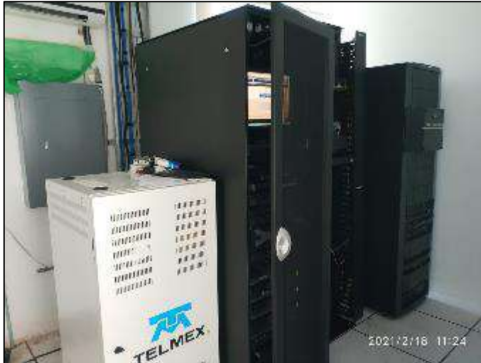
Site en Plaza de cobro "Tintal", en buenas condiciones, km 237+700.
