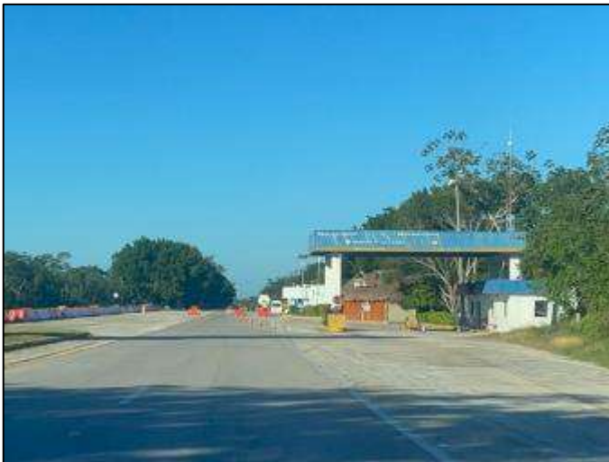
Aduana de Cancún, condiciones regulares, se sugiere mantenimiento de pintura, km 217+000.
