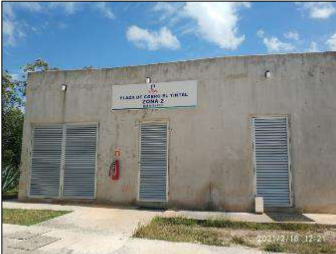
Zona 2 Plaza de cobro "Tintal", en buenas condiciones, km 010+200.
