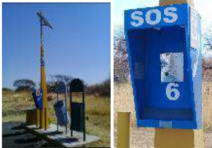
Puntos de SOS con concertina para evitar vandalización, área limpia, botes bien colocados y con separación de residuos, en caso de que la SOS no pueda conectar con la operadora, cuenta con un teléfono para que el usuario pueda comunicarse desde el móvil personal.
