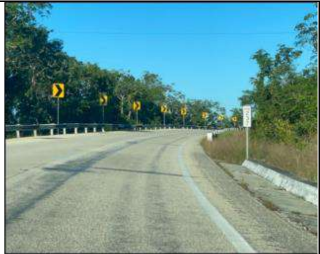
Pavimento, señalamiento vertical, barrera central y defensa metálica
