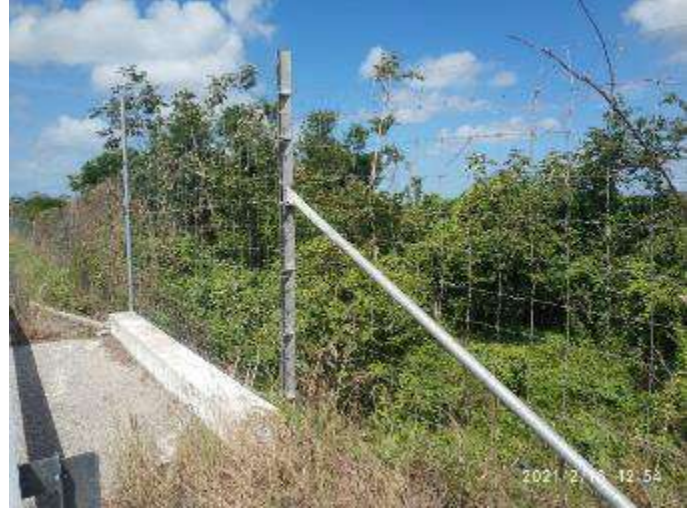
Paso de Fauna, "Tintal-Playa de Carmen", buenas condiciones, km 238+000.
