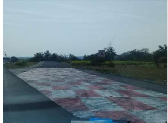
Rampa de desaceleración, bien señalizada, como esta hay 3 en el tramo 2
