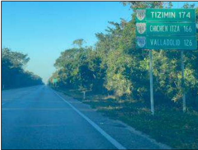
Señal informativa de destino, en buenas condiciones físicas, km 279+000.
