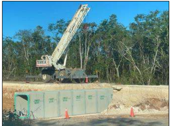
Obra en proceso de Cancún-Kantunil, km 196+000 y terminación en el km 176+00, aproximadamente km 20.
