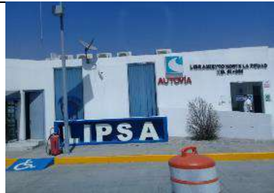
Oficinas de caseta troncal en buen estado, limpias, con los servicios necesarios para la plantilla de trabajo, seguridad suficiente en el área de ingresos.
