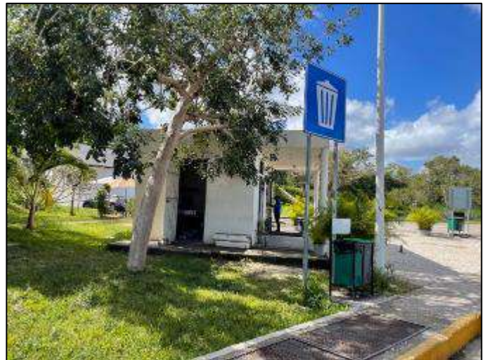
Área de cafetería caseta de cobro "Chichen-Itzá" en buenas condiciones, km 115+500.
