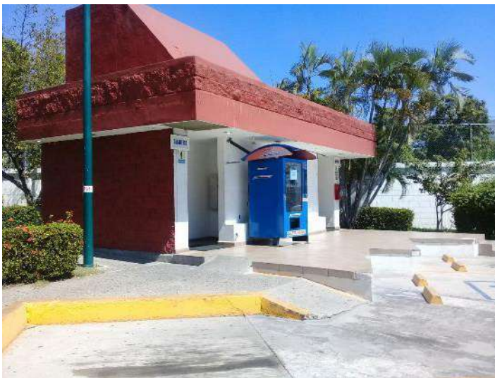
Sanitarios para el servicio del usuario, en buenas condiciones físicas.
