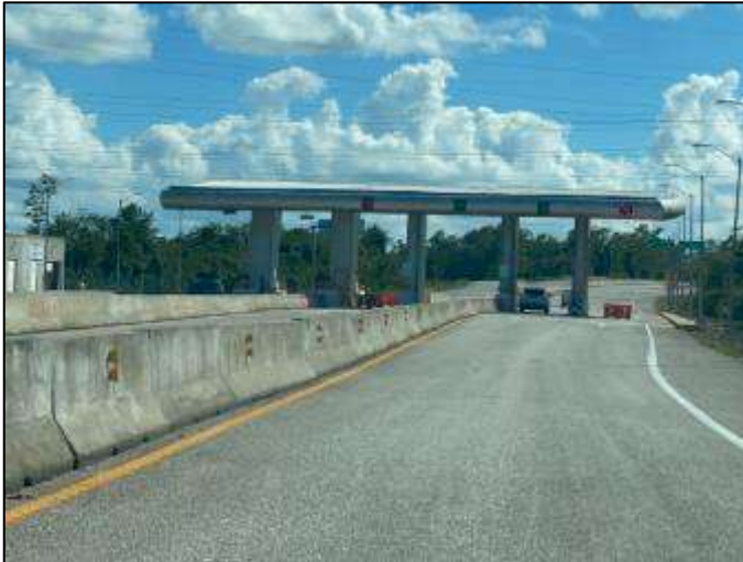
Zona 1 Plaza de cobro "Tintal", en buenas condiciones, km 010+300.
