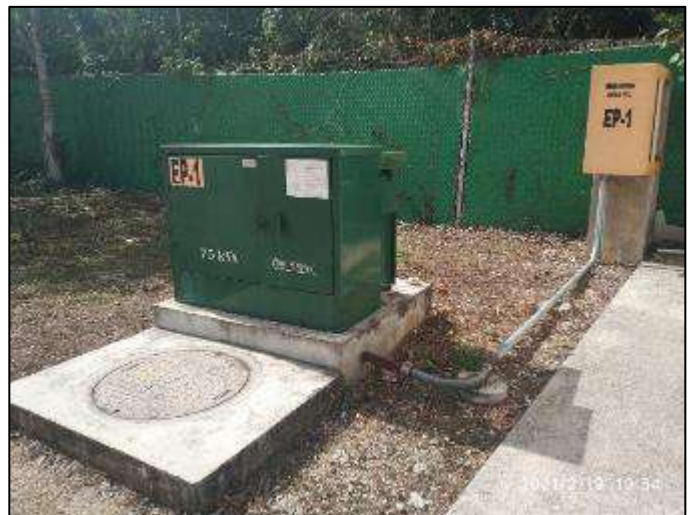
Zona 3 Plaza de cobro "Tintal", en buenas condiciones, km 049+700.
