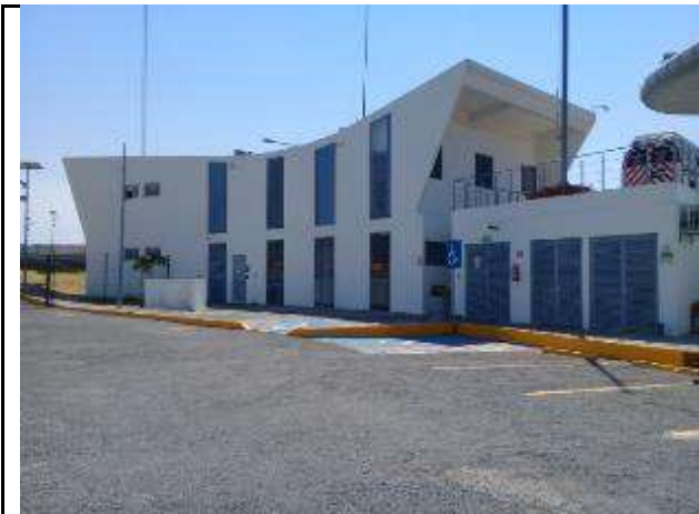
En la fotografía se observa los dos pisos de las oficinas de la caseta troncal, el cuarto de máquinas y la base de la ambulancia (2 paramédicos 24x24hrs)
