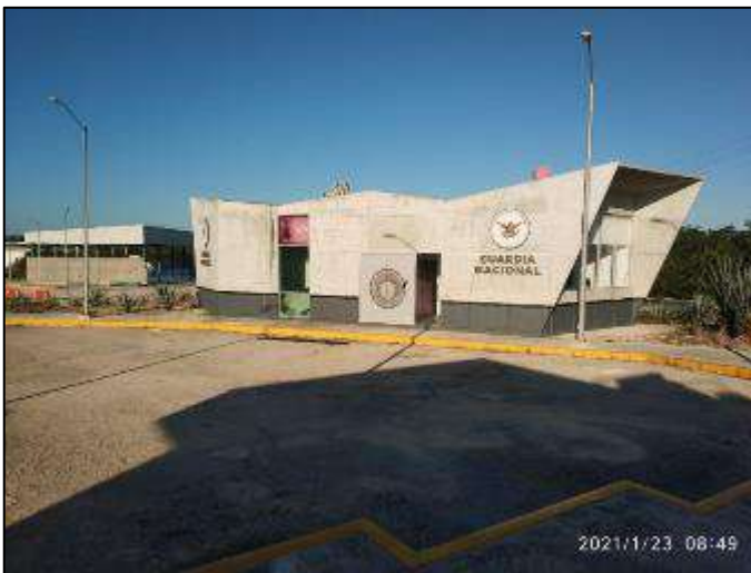
Instalaciones de Guardia Nacional, en Plaza de cobro "Tintal", en buenas condiciones, km 237+700.
