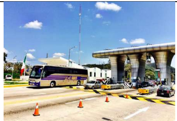
Plaza de cobro troncal Rayón con 4 casetas de cobro, servicios conexos en funcionamiento, km 2+000
