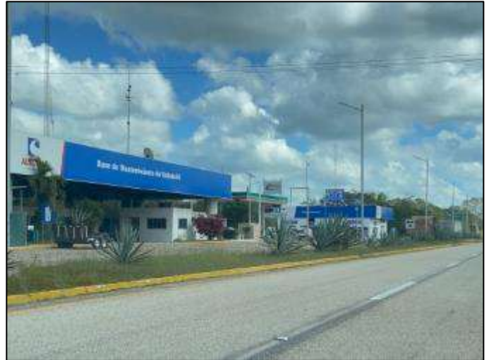
Área de servicio Kantunil-Cancún, se encuentra restaurantes, gasolinera y base de mantenimiento, buenas condiciones, 150+000.
