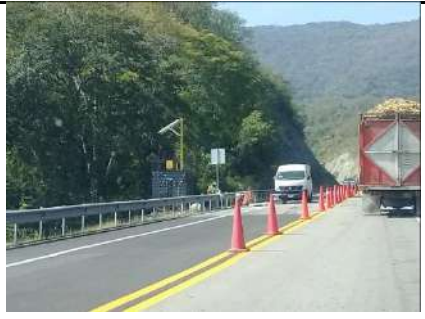
Trabajos de mantenimiento de la estación de medición (HI-TRAC-TMU4)
