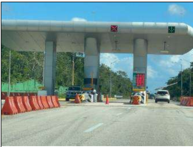
Zona 3 Plaza de cobro "Tintal", en buenas condiciones, km 049+700.
