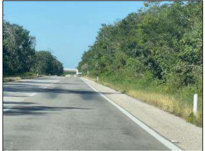
Indicadores de alineación, en buen estado, se requiere mantenimiento de corte de maleza, km 144+000.
