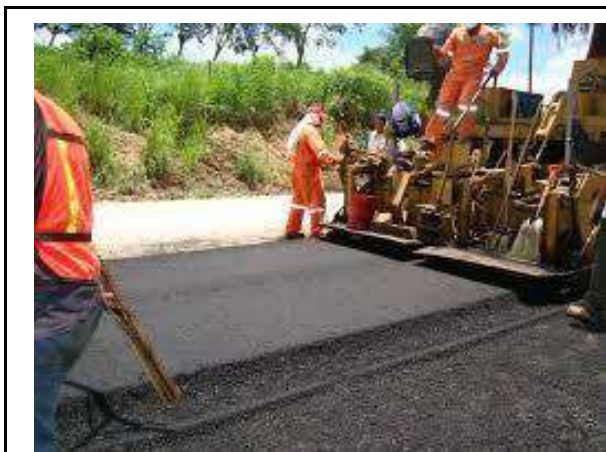
Imagen ilustrativa: Mezclas asfálticas en caliente tienen como función completar la estructura superior de una obra vial o pavimento.
