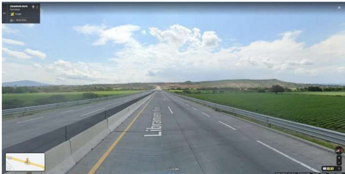
Figura 2.2: Tramo del Libramiento La Piedad
