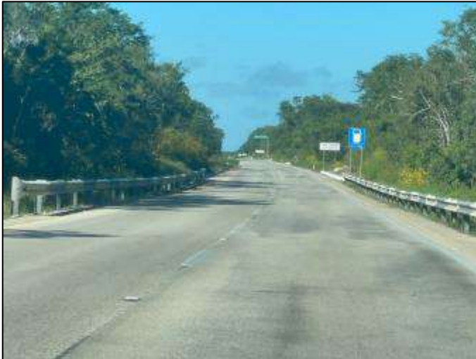
Barrera de orilla de corona rígida, en buen estado físico, km 150+000.
