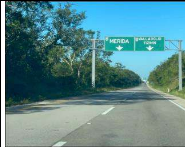
Detalle pavimento con señalamiento horizontal y raya discontinua.
