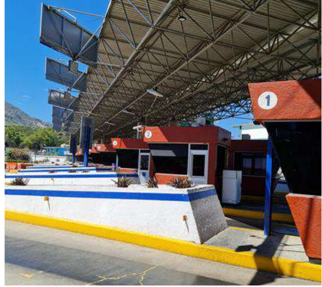
Jardineras fungiendo como barreras de delimitación en plaza de cobro, en buenas condiciones físicas.
