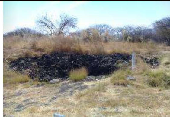
Zanja realizada en Km 93+000 para evitar accesos clandestinos
