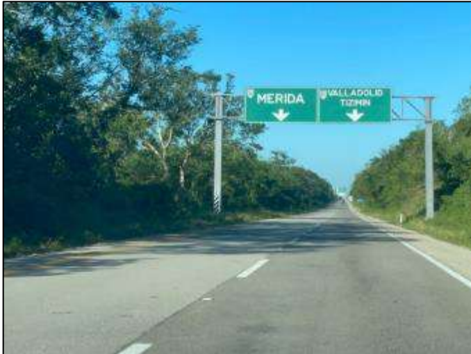
Raya blanca continua y raya blanca discontinua sencilla, en buenas condiciones, km 157+000.
