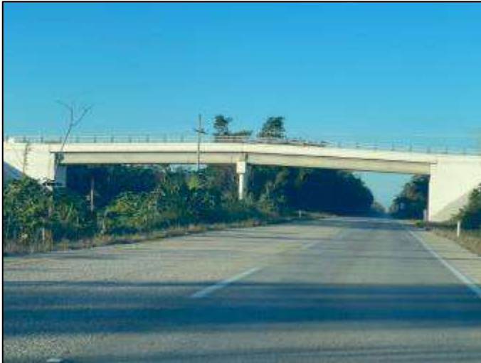
Paso inferior vehicular, buenas condiciones, km 285+000.
