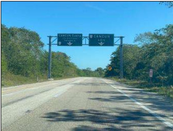
Indicadores de obstáculos, sentido Kantunil-Cancún, en buen estado físico, km 67+000.
