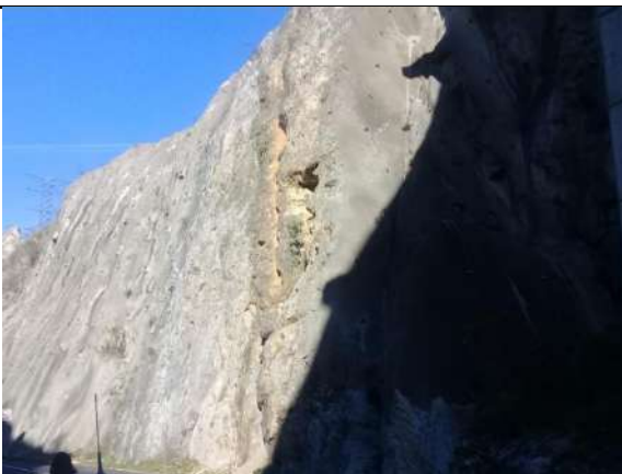
Ejemplo de corte estabilizado con drenes y concreto lanzado
