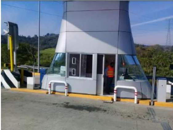
Caseta auxiliar Tamasopo, con un auxiliar para ocuparse de ambos sentidos, cuenta con una máquina de ticket y otra que expide boleto con cinta magnética, cámara de domo, cortina óptica, barrera, cámara de placas y panorámica
