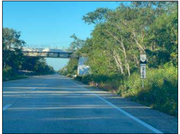
Señal informativa de identificación, en buenas condiciones físicas, km 265+000.
