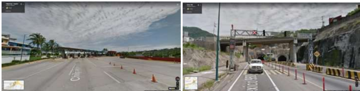
Figura 2.2: Tramos del Maxitúnel de Acapulco
