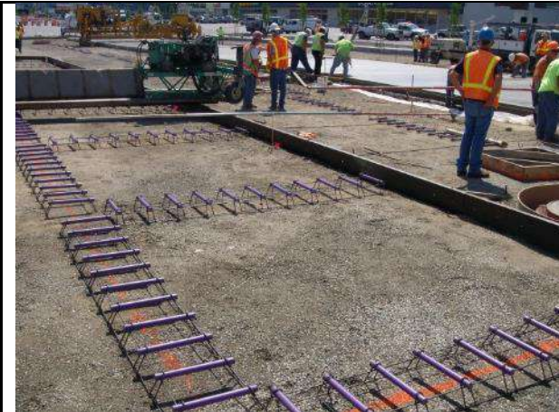
Imagen ilustrativa: Base hidráulica terminada, sobre esta se coloca la canastilla metálica con pasajuntas de redondo de acero. Según el método constructivo esto puede ser llevado a cabo en un solo proceso.
