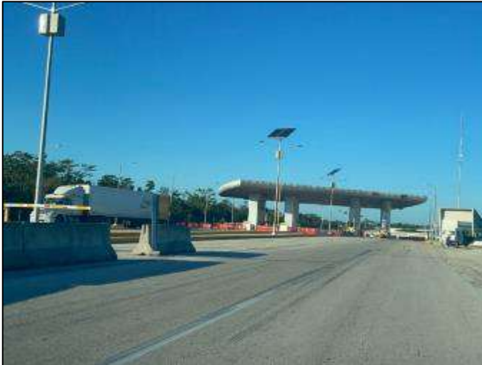
Plaza de cobro "Tintal", en buenas condiciones, km 237+700.
