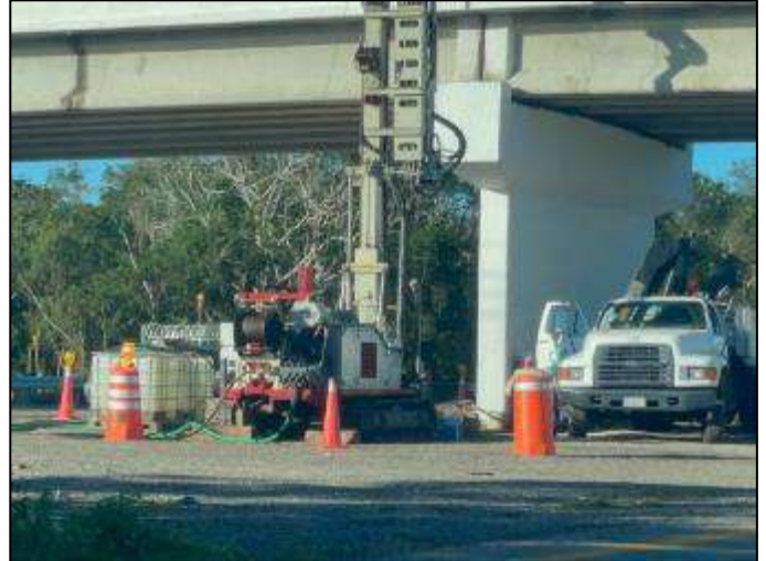
Sondeos realizados por CFE, km Entronque "Tintal-Playa de Carmen", buenas condiciones, km 227+500.
