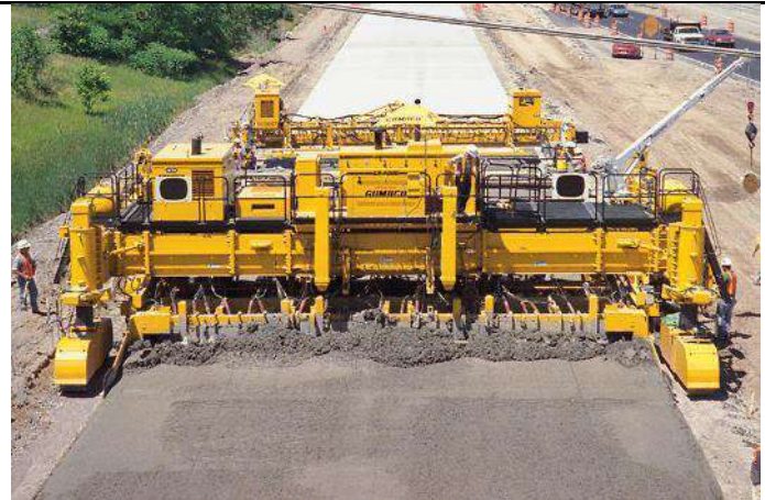
Imagen ilustrativa: Extendedora de encofrado deslizante - GP-4000. El equipo hace la colocación de barras, regula el espesor definido, el terminado final es el único proceso manual.
