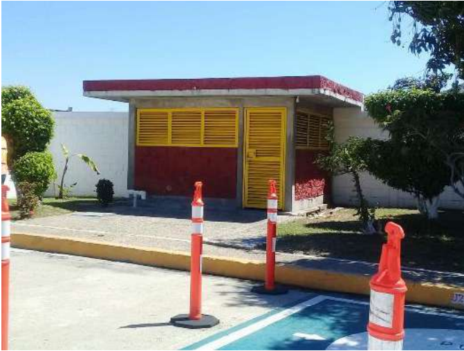
Bodega de insumos para mantenimiento, en buenas condiciones físicas.
