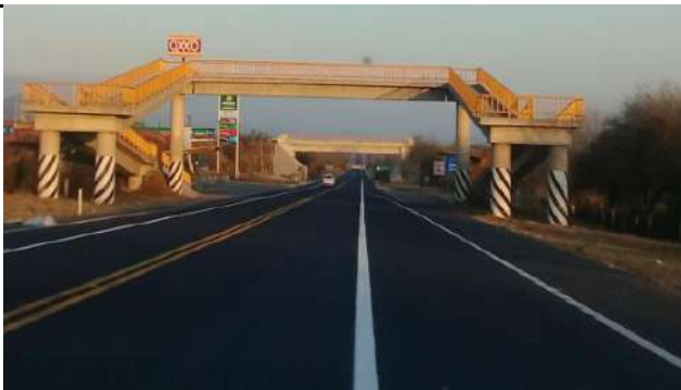
Estructura en buen estado, la operadora se encarga de la limpieza, el buen estado y la pintura.
