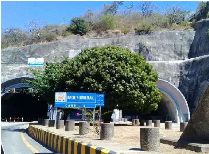
Señal informativa de peaje, en buenas condiciones físicas.
