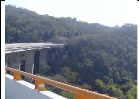
Parapeto con pintura reciente en puente el nacimiento
