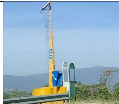
Estación SOS, cuenta con una pileta de agua, dos botes de basura con descripción para reciclaje, panel solar y botón de llamada al centro de operaciones del tramo carretera.
