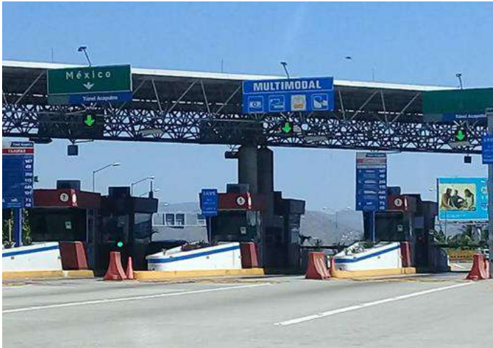
Plaza de cobro Las cruces, en buenas condiciones físicas.
