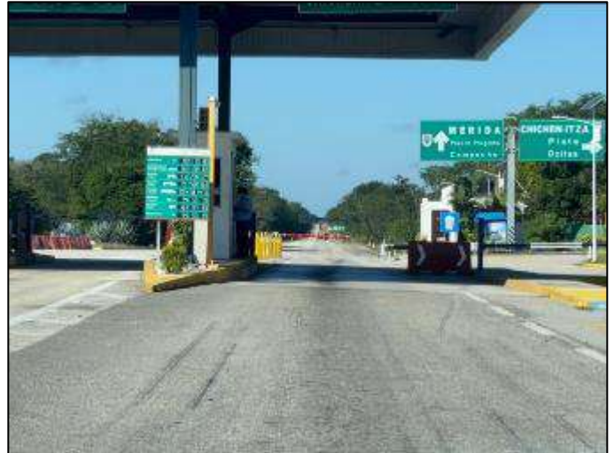
Plaza de cobro "Chichen-Itzá", en buenas condiciones, km 115+500.
