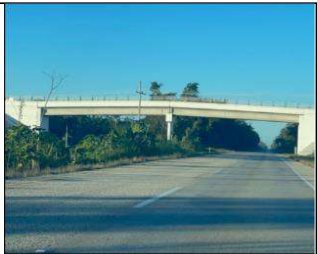
Puente Inferior Vehicular km 285+000
